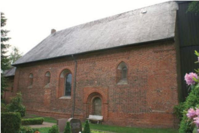
Der Zahn der Zeit hat kräftig genagt und ein Gutachten des Architektenbüros Fröhler aus Eckernförde wurde eingeholt. So bestehen Frostschäden an Sockelbereich und Mauerwerk, an einem Fenster sind Setzungsrisse erkennbar, eine Reihe der Wulststeine der Sockeloberkante sind zerstört, ebenso Rundstabformsteine in der linken Laibung des Nordportals.
